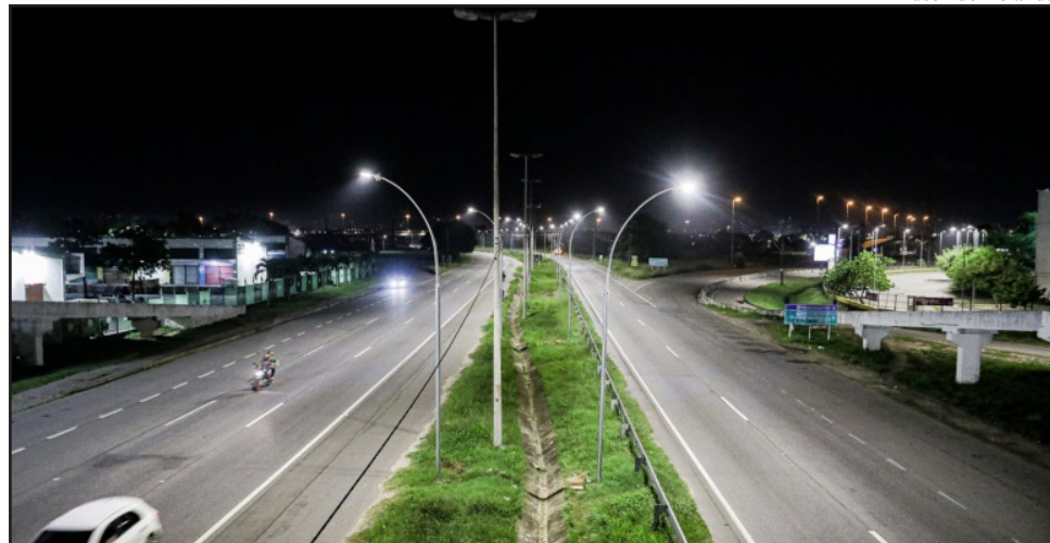
Trecho entre o viaduto da BR-232 e o viaduto do CEASA já conta com novas luminárias, que trazem maior segurança e conforto para quem passa na rodovia
