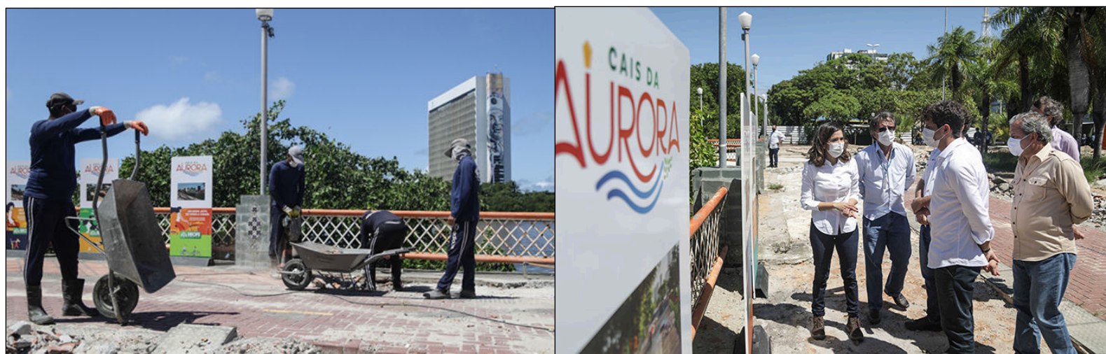
Prefeito João Campos vistoriou ontem (17) as obras das varandas 3 e 4, que já estão sendo executadas e fazem parte da primeira etapa do projeto
