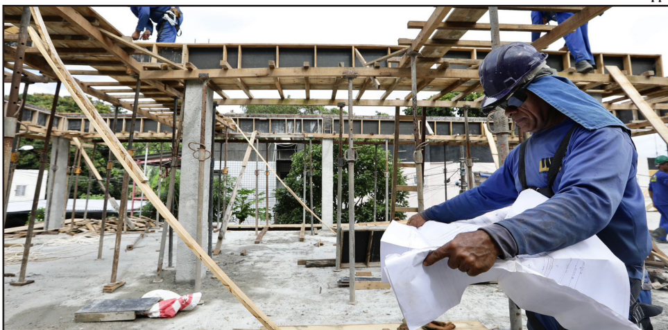
Com investimento em torno de R$ 4 milhões, as obras da nova sede da Escola Municipal Casa dos Ferrovários e da ampliação da Creche Tancredo Neves fazem parte do projeto de criação de novas vagas na rede municipal
