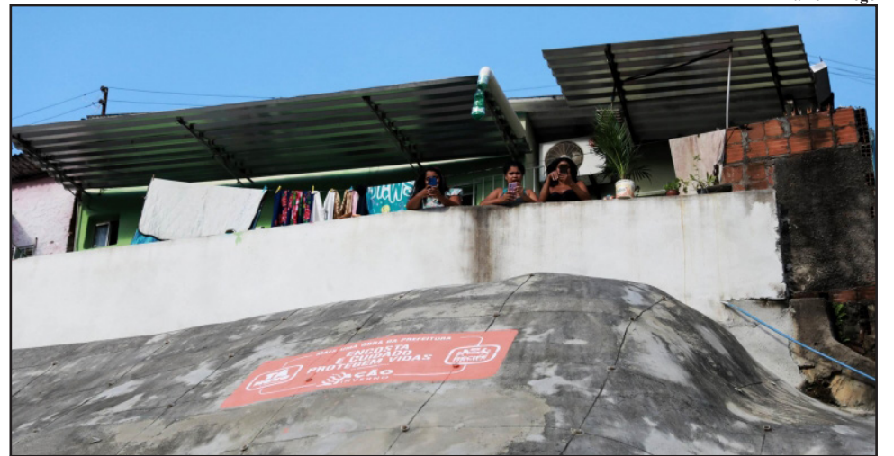
As contenções das encostas das ruas Bilac, Urânia e 2ª Travessa da Rua Quarenta, além da requalificação do Largo da Bomba do Hemetério, foram inauguradas no sábado (25)
